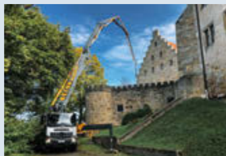
Técnica de hormigón
