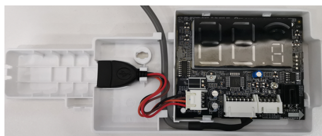
Image 4 - Placement des câbles
